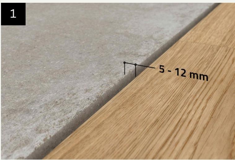
Die Breite der Übergangsfuge sollte zwischen 5 und 12 mm sein. Ebenfalls zu berücksichtigen ist die Stärke des Bodenbelags. Unsere Systeme des Typs X5 können bereits ab einer minimalen Bodenbelagsstärke von 5 mm eingesetzt werden.
